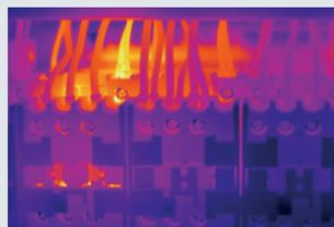
**Faça manutenção de sistemas:** Identifique temperaturas excessivamente altas nos disjuntores e componentes elétricos antes que ocorram falhas.
