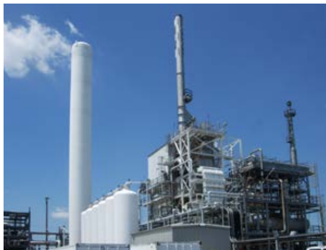
Reformador de metano a vapor (SMR), cluster de hidrogênio em Lima, Ohio – copyright Matheson Tri-Gas
