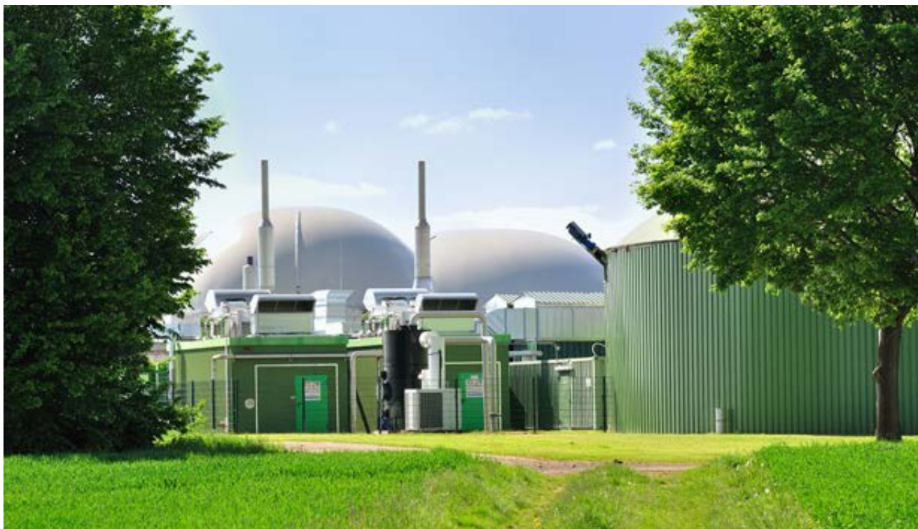
Usina de biogás com unidades de upgrade de biometano e CHP
