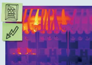
**Manutenção de plantas:** Identifique temperaturas excessivamente altas em disjuntores e componentes elétricos antes que possam ocorrer avarias.
